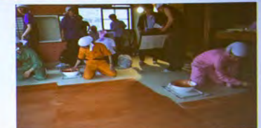
・混ぜた液を床前面に塗る様子
